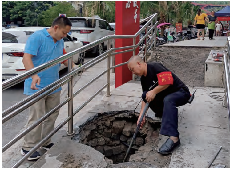
图为居民自发维修下水管道。
