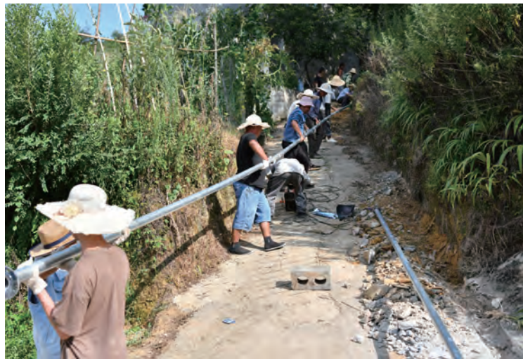
寨乐镇革新社区群众安装水管。 【周啟刚 / 摄】
