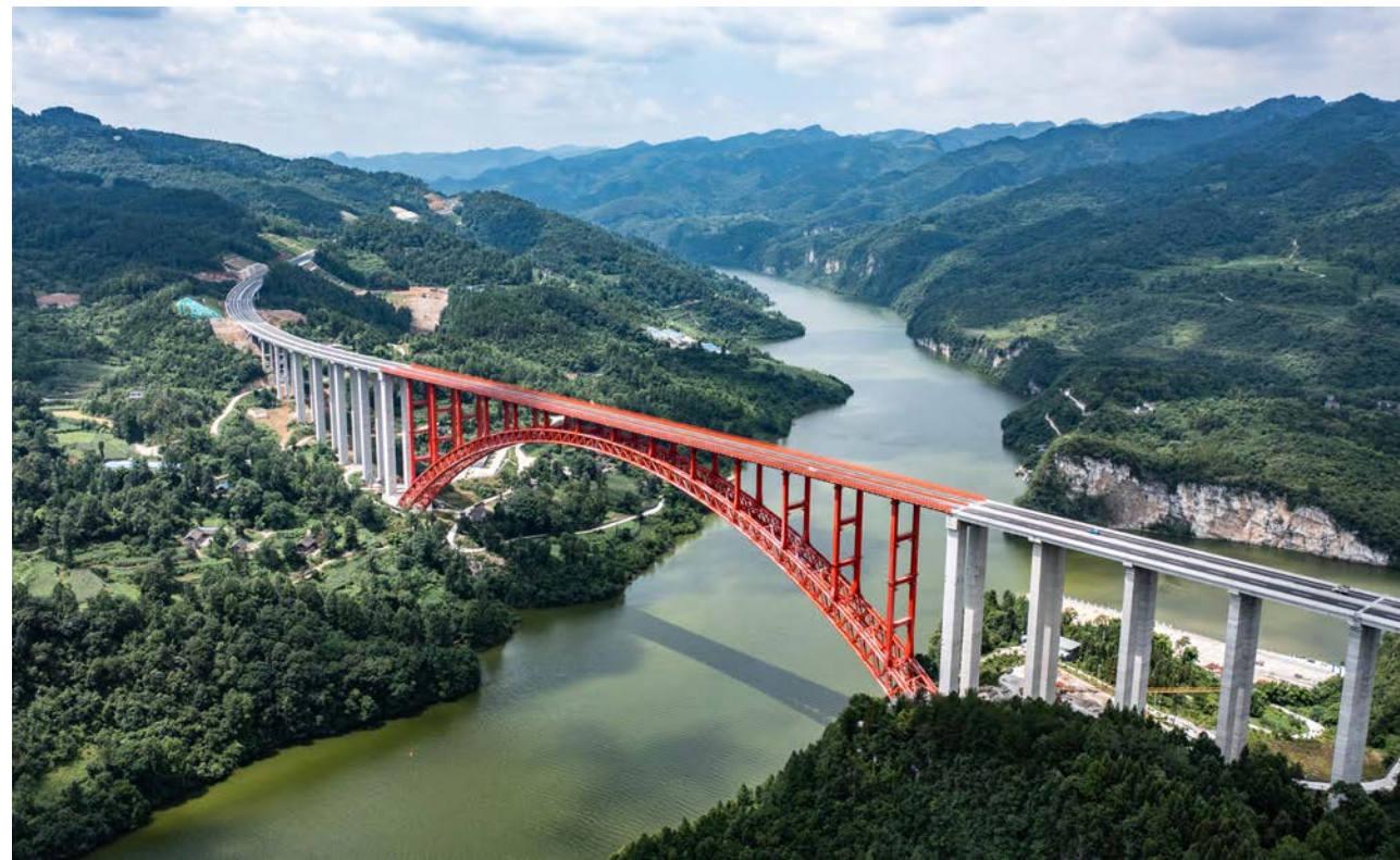
德余高速公路乌江特大桥。[新华社记者 陶亮 / 摄]
