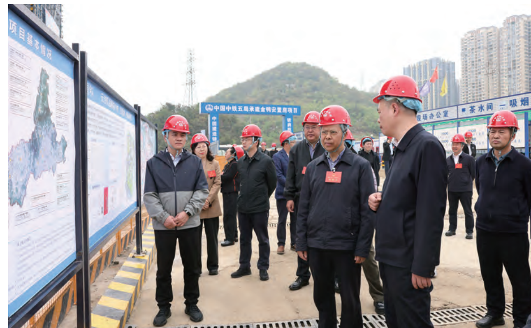
4月8日，省人大常委会组织部分在筑全国人大代表、省人大代表及贵阳市人大代表赴贵阳市开展安置房建设情况视察活动。图为代表们在视察云岩区金鸭安置房项目建设情况。
