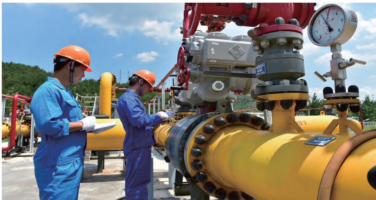
加强城镇燃气管理，保障燃气供应，防止和减少燃气安全事故，省十三届人大常委会审议了《贵州省城镇燃气管理条例（草案）》。图为工人正在检修燃气管道。
